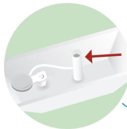
Jogue talco ou pó de café na caixa acoplada. Se o talco ou pó de café for para o tubo "ladroão" da caixa, há vazamento. É necessário regular a bóia da caixa ou trocar o kit de reparo.
